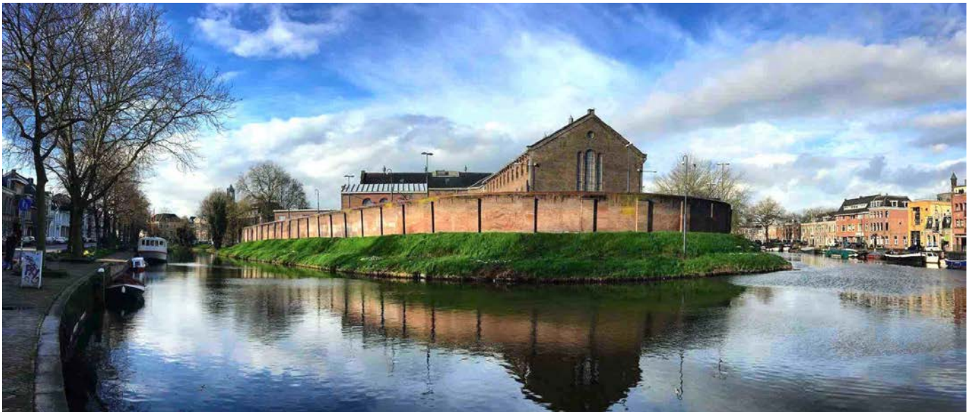
Complex gezien vanaf de overzijde van de singel , foto Marco Geijtenbeek, 2017
